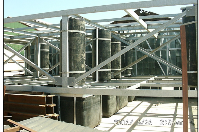
Εξέδρα κατακόρυφης αγκυροβολίας (πλωτός Κ/Α) κατά τη φάση της εγκατάστασης
